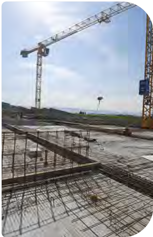
Chantier du Collège de Mercurol-Veunes
