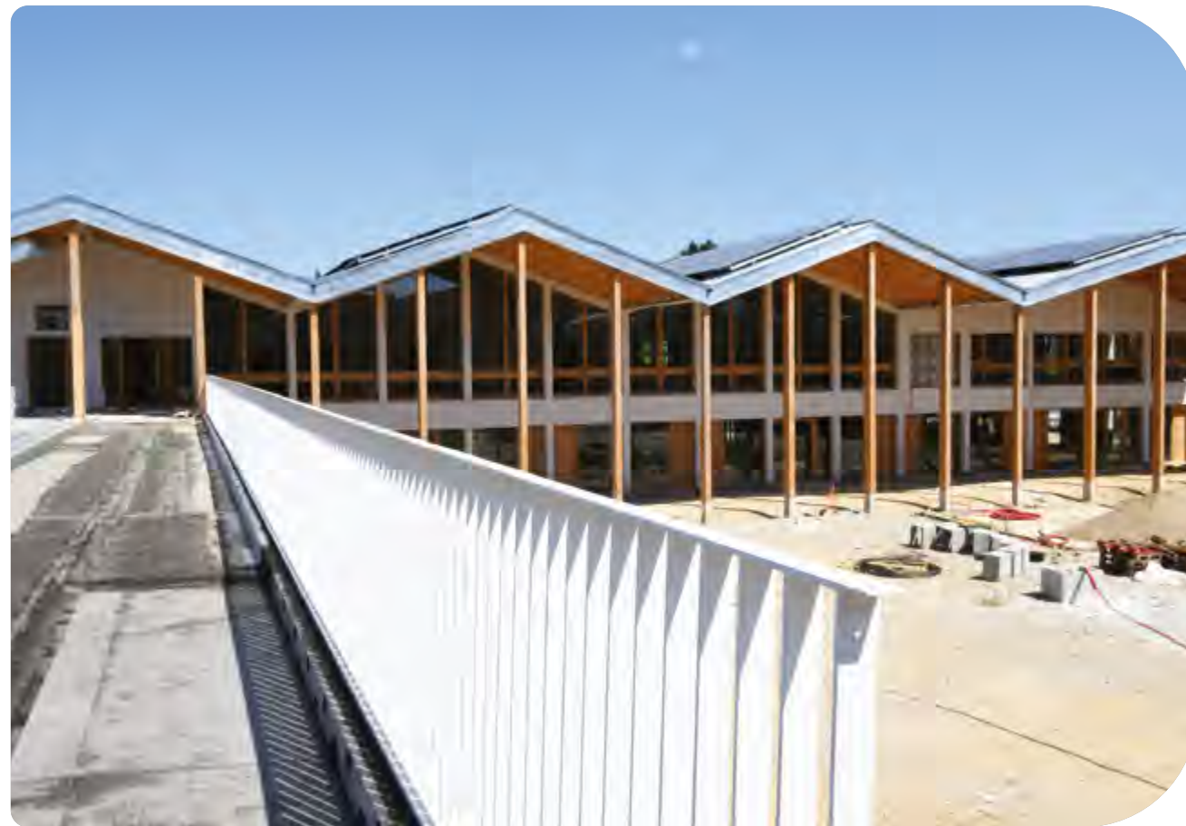
Chantier du Collège de Saint-Donat
