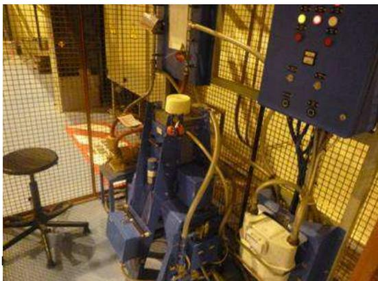
2/ Appareil de prélèvement des aérosols sur filtre installé en aval des filtres THE et avant rejet à la cheminée (système APA) :
