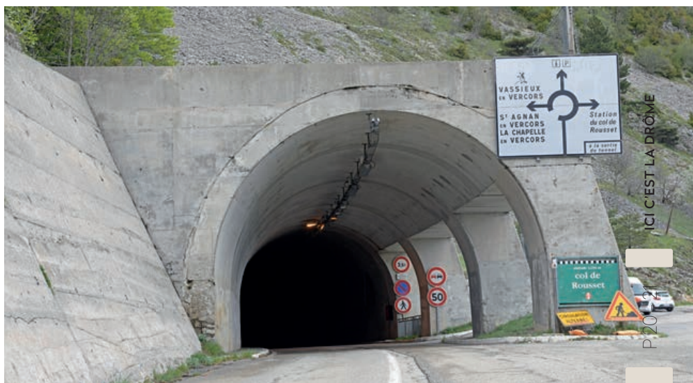
Le tunnel du col de Rousset
