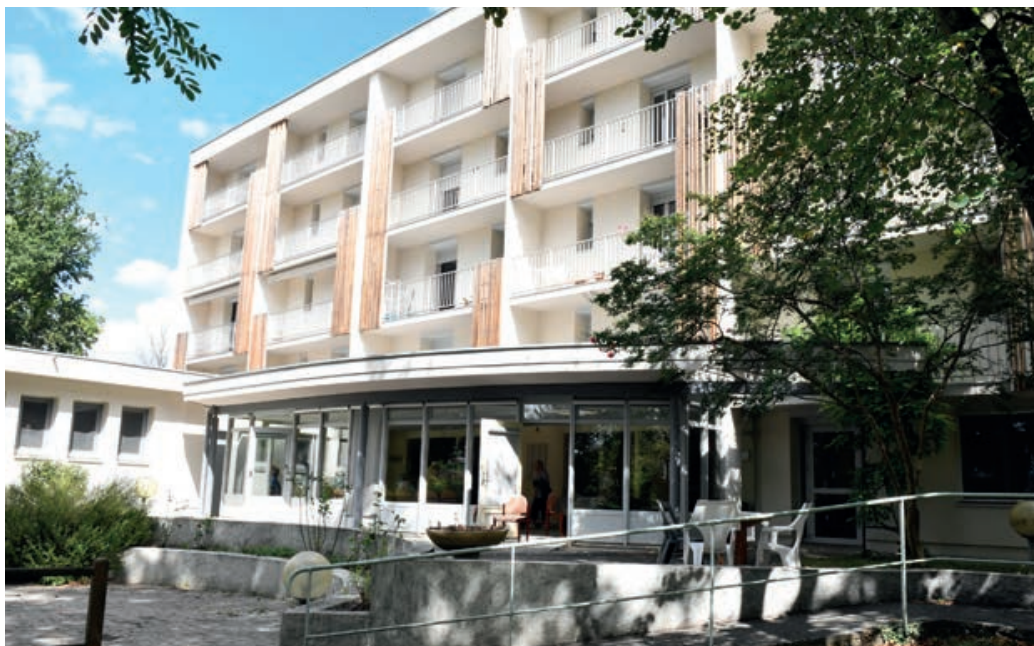
« Résidence du parc », résidence autonomie à Loriol-sur-Drôme
