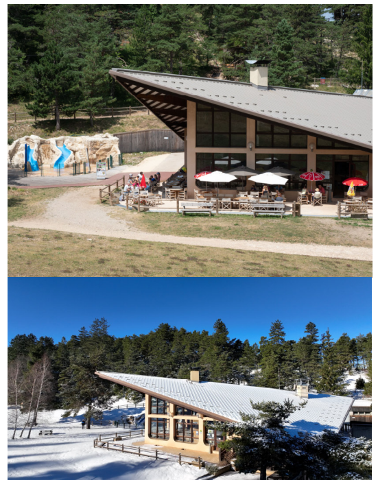
Photos aériennes du bâtiment principal (été/hiver)
