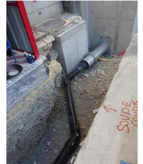
Création du puits et injection sous le bâtiment contenant la bache d'alimentation de secours des générateurs de vapeur
