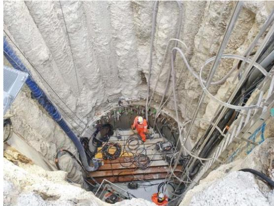
Mise en place d'un réseau enterré afin d'alimenter durablement le réservoir d'eau des générateurs de vapeur et des piscines par la source d'eau de l'appoint noyau dur.
