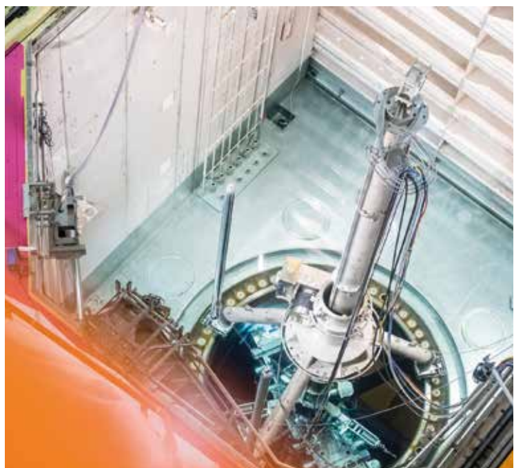
Inspection de la cuve du réacteur
