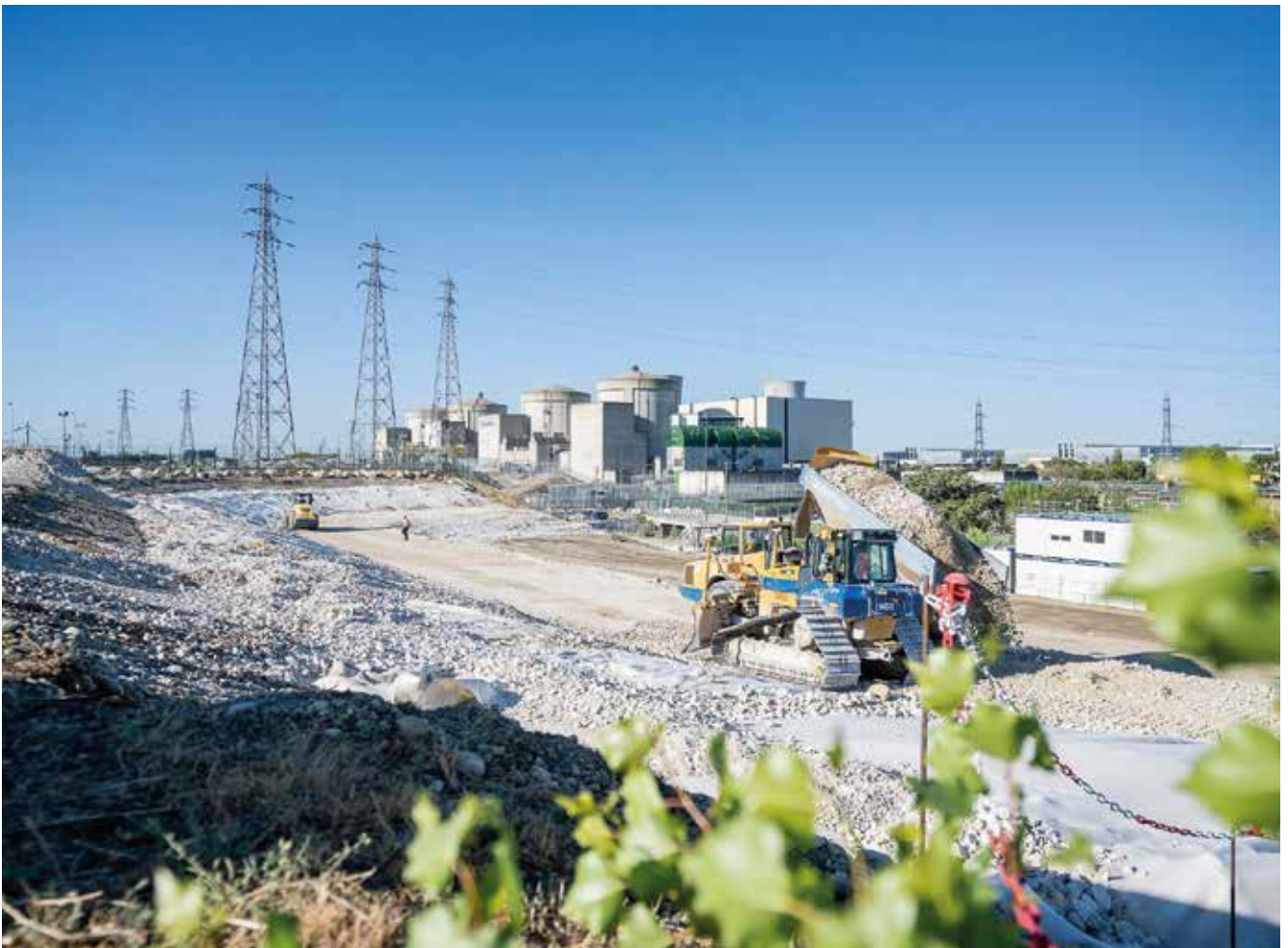
Travaux de renforcement de la digue
