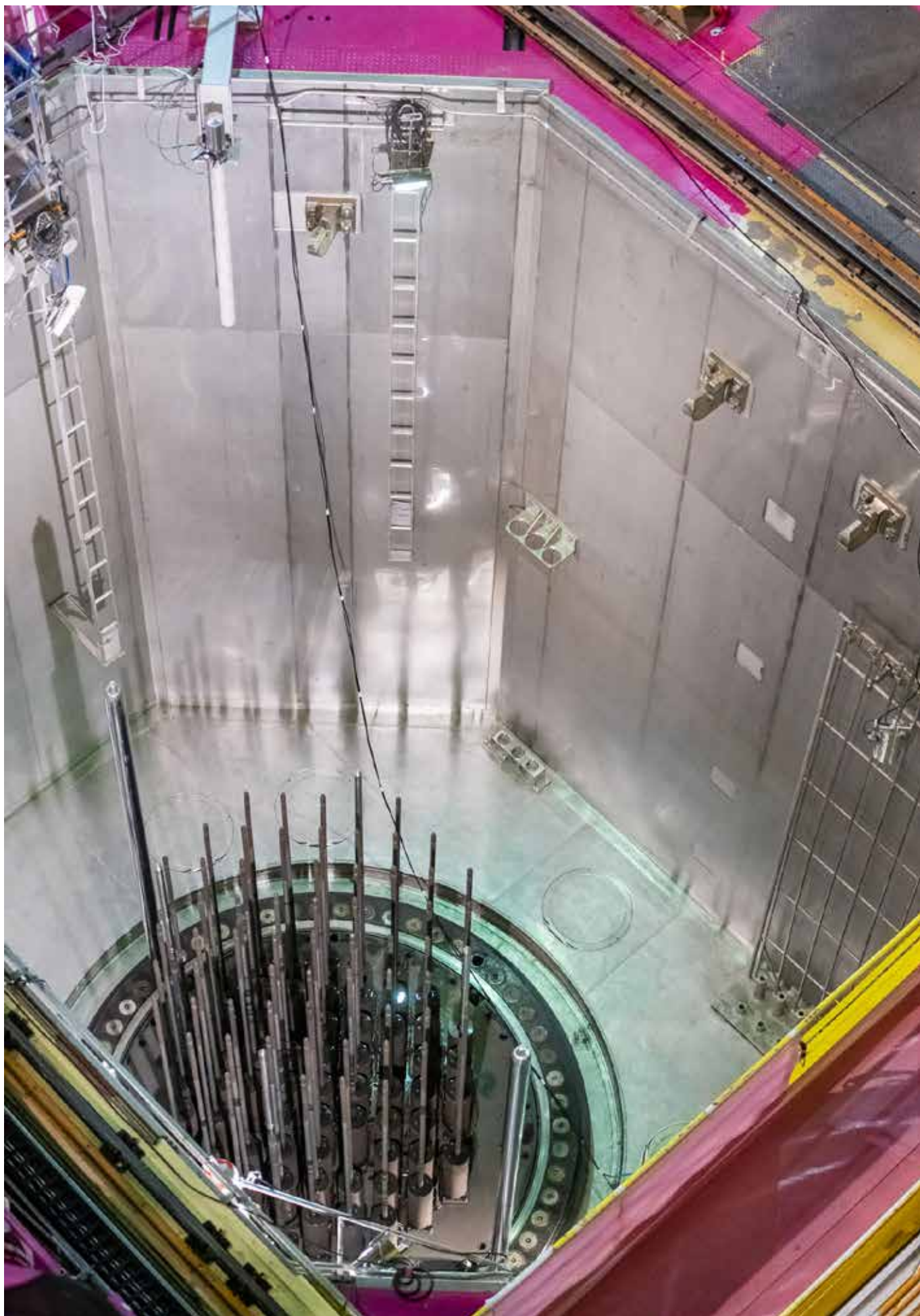
Les tiges des grappes de commande du réacteur.
