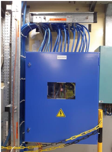
Mise en place du tableau LUU (DUS)
