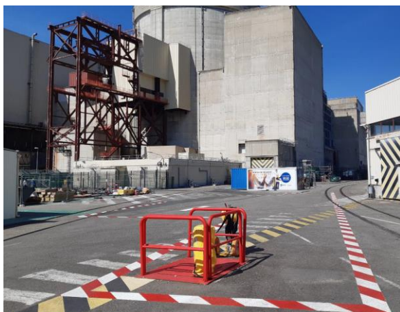
Marquage emplacement Unité Mobile de Boration (UMB)
