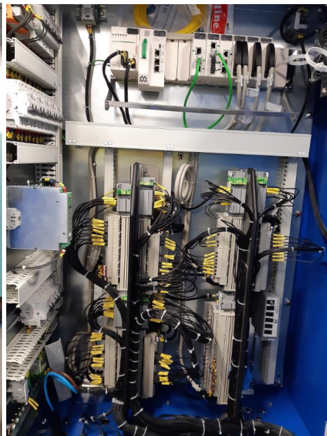
Mise en place du tableau LUU (DUS)
