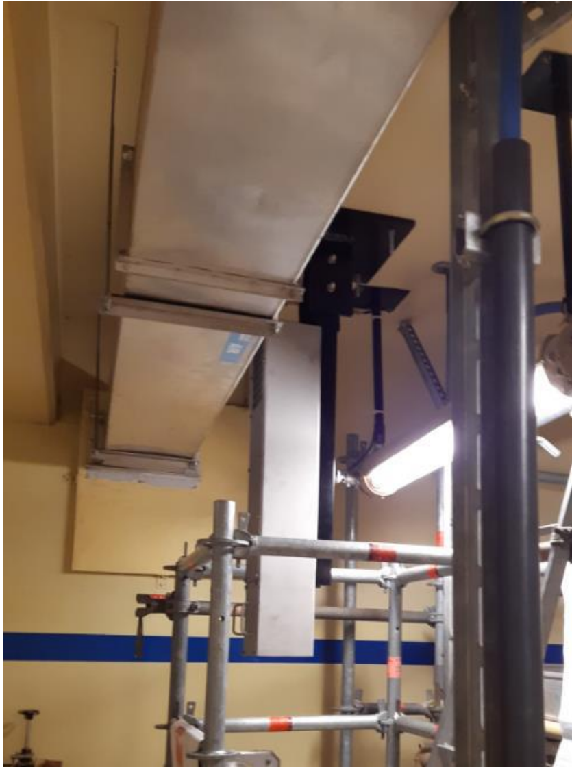
Ajout d'un Recombineur Autocatalytique Passif (RAP) local batterie
