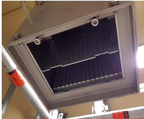
Ajout d'un Recombineur Autocatalytique Passif (RAP) local batterie
