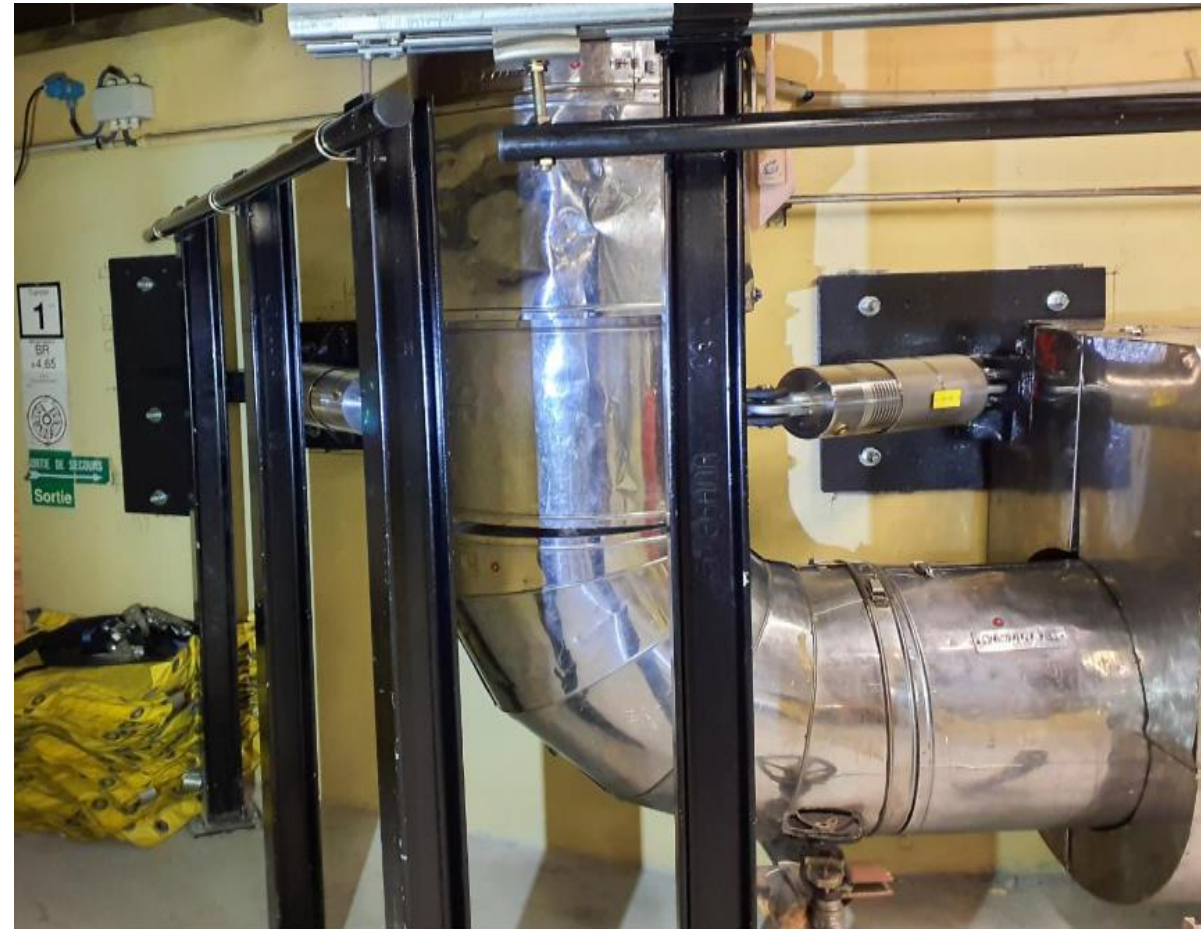
Ajout de supports sur le Circuit Secondaire Principal
