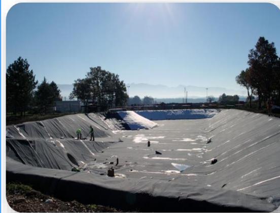
Réfection des réseaux d'eaux pluviales et création de 2 bassins de confinements
