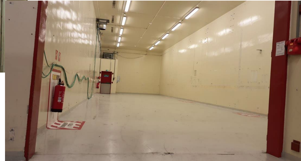
Un local dans l'état quasi final avant la suppression des éclairages, prêt pour l'assainissement
